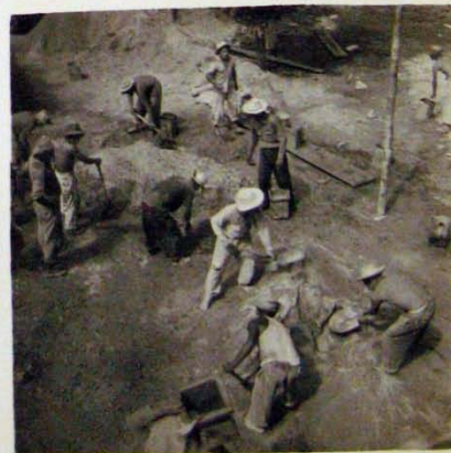
Fig.12.- Preparación de la -mezcla de cemento, arena y grava.
