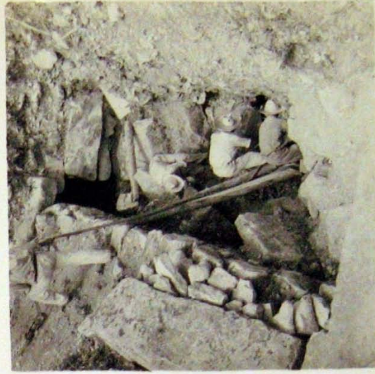
Fig. 40.- Retirando las piedras caídas de los muros y bóveda del Acueduc- to.
