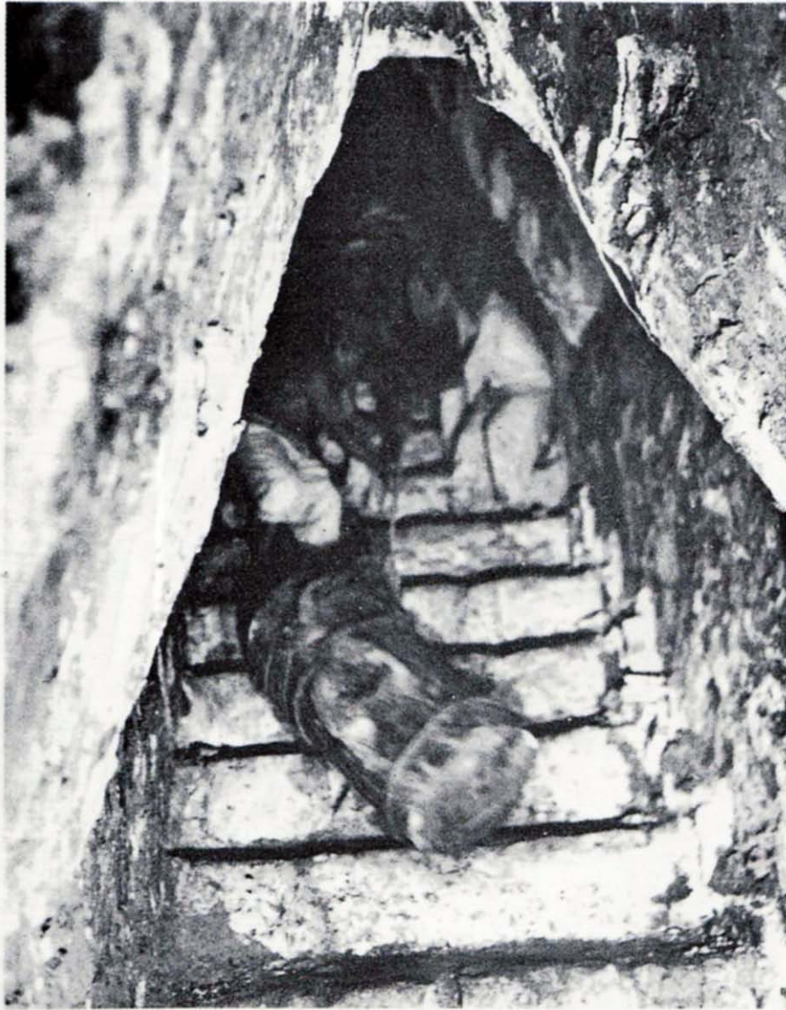
FIGURA 23. Vista parcial del segundo tramo de escalinata (el más profundo), en el interior del basamento piramidal del Templo de las Inscripciones que conduce a la cámara funeraria. En la ilustración se muestra como se hizo el descenso de los gruesos troncos para sostener elevada la gran lápida para poder abrir el sarcófago. En la vista anterior (fig. 22) y en ésta, se aprecian claramente los distintos tipos de arco maya empleados en cada tramo de la escalinata. Palenque, noviembre de 1952.
