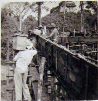
Fig. 9.- Colando trabes de concreto.
