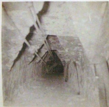
Fig. 32.- Primer tramo de la escalera in- terior del Templo de las Ins- cripciones, con el malacate uti- lizado para sacar el relleno. (visto desde arriba).
