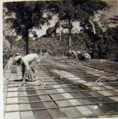
Fig.10.- Preparación del armazón para el techo.
