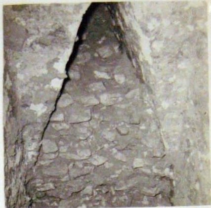
Fig. 31.- Descanso de la escalera interior del Templo de las Inscripciones, mostrando el relleno de piedras y barro.
