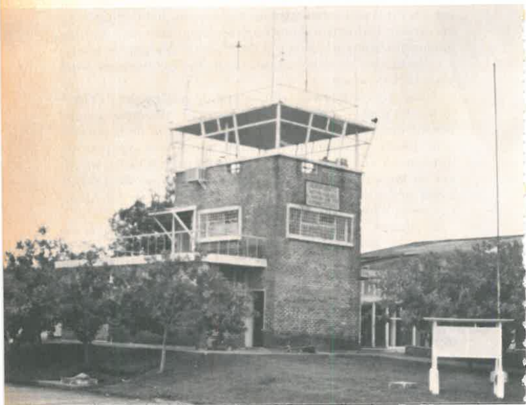
TORRE DE CONTROL. BASE RAYO (RETALHULEU).
