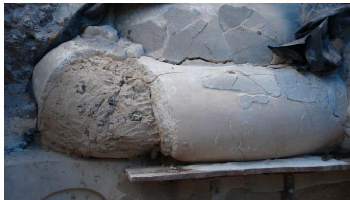
Figura IV-13: Detalle de la mejilla derecha del Mascarón Norte durante la intervención de consolidación (Foto por Alice Desprat).
