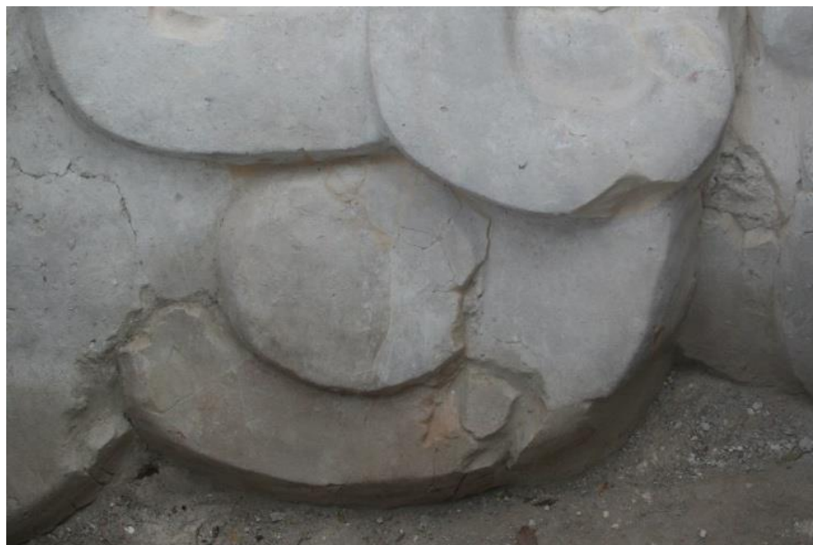
Figura XII-16: Detalle de la misma zona después de la intervención (Foto por Alice Desprat).
