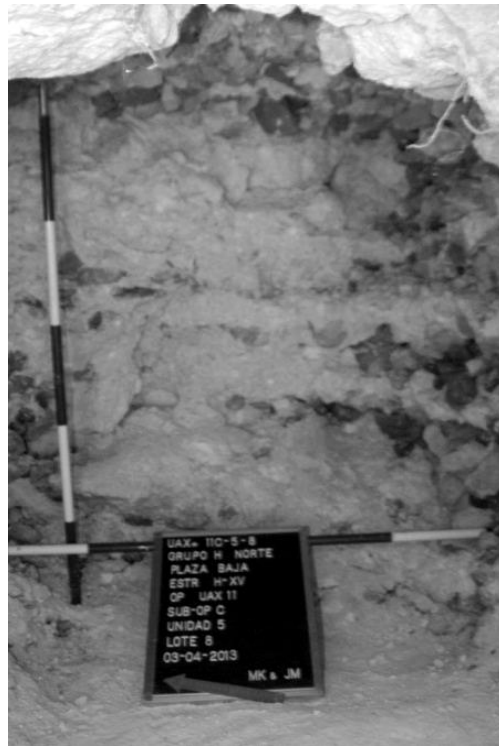
Figura V-8: Tercer muro de contención y encajonamiento en el túnel (Foto por J. Méndez)
