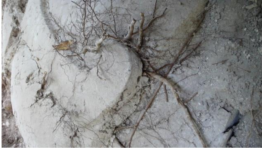
Figura XII-8: Detalle del crecimiento de raíces en el estuco (Foto por Alice Desprat).
