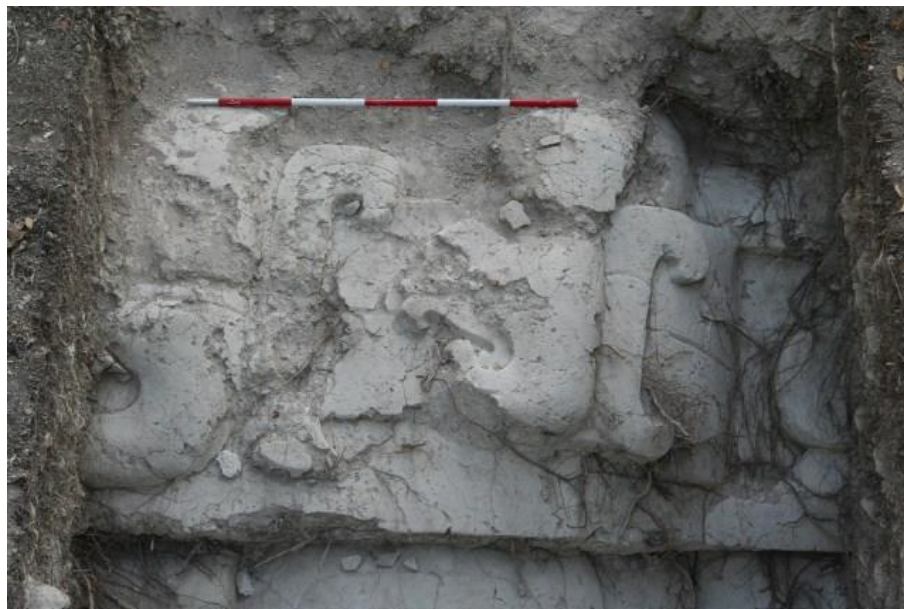
Figura XII-10: Detalle de la disgregación del estuco en la parte superior del mascarón (Foto Alice por Desprat).
