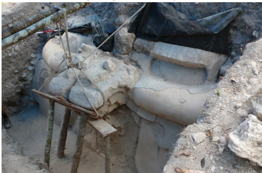
Figura IV-6: Detalle del sistema de apuntalamiento durante las operaciones de excavación en el Mascarón Norte (Foto por Alice Desprat).
