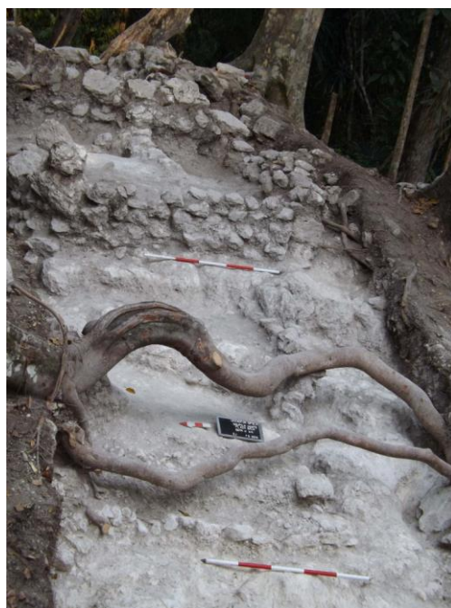
Figura VI-10: El cuarto y quinto cuerpo de la estructura destruidos (Foto por E. Jobbová)
