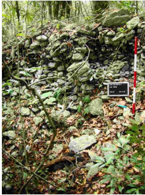
Figura XXI-36: Restos constructivos visibles de la estructura RSE12-II (Foto por T. Drápela).
