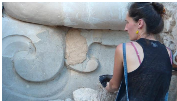
Figura IV-10: Vista general del muro de soporte realizado debajo de la nariz del Mascarón Sur (Foto por Enrique Pérez Zambrano).
