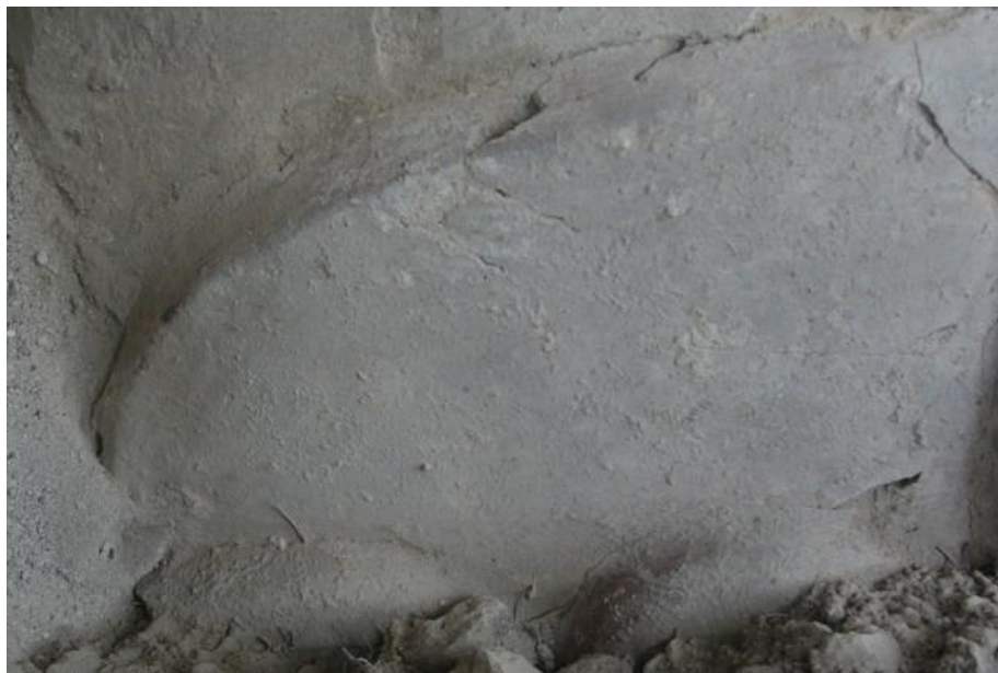
Figura XII-11: Detalle de capa opaca muy dura sobre el estuco (Foto por Alice Desprat).
