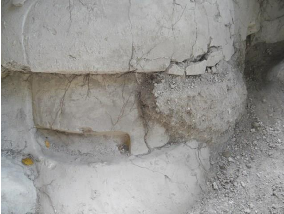
Figura XII-12: Detalle del desprendimiento de una sección de la ceja izquierda antes de la intervención (Foto por Miguel Medina).
