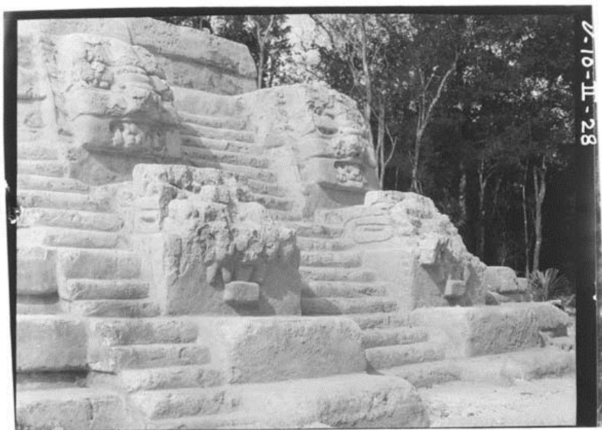
Figura XIII-37. Vista de la fachada Norte de la Estructura E-VII-Sub al momento de su descubrimiento en 1929 (Foto tomada de Institución Carnegie de Washington, crédito Harvard Library).
