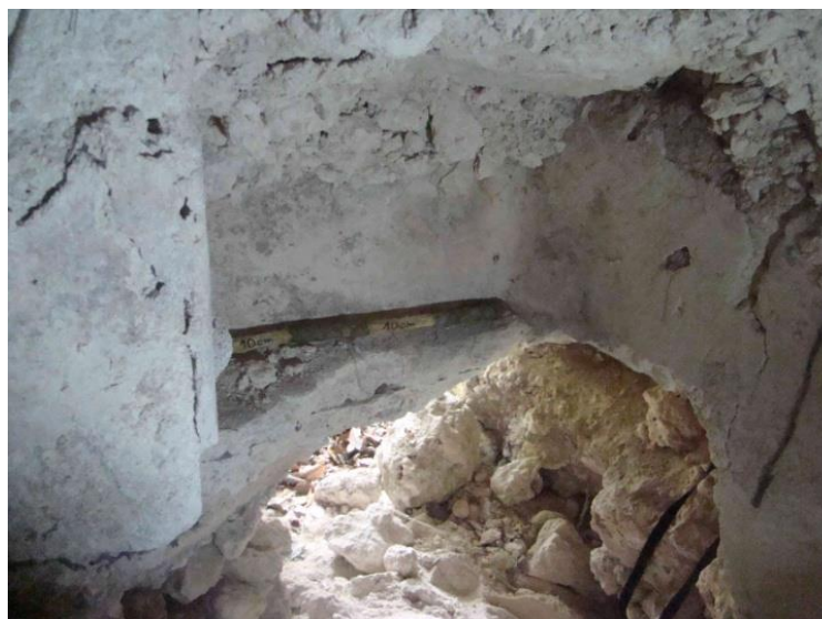
Figura XXI-41: Interior del edificio RNE6-oeste-I-A (Foto por T. Drápela).
