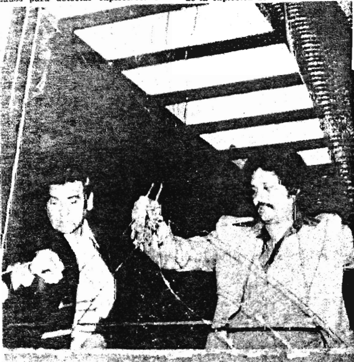
NUESTRO GERENTE de producción, Sr. Joe Montoya (a la izquierda) inspecciona los daños causados junto al superintendente de nuestro edificio, Sr. Roberto Dones, después del estallido de la bomba de dinamita que terroristas anti-castristas depositaron en las oficinas de EL DIARIO-LA PRENSA. (Foto por Arellano).
