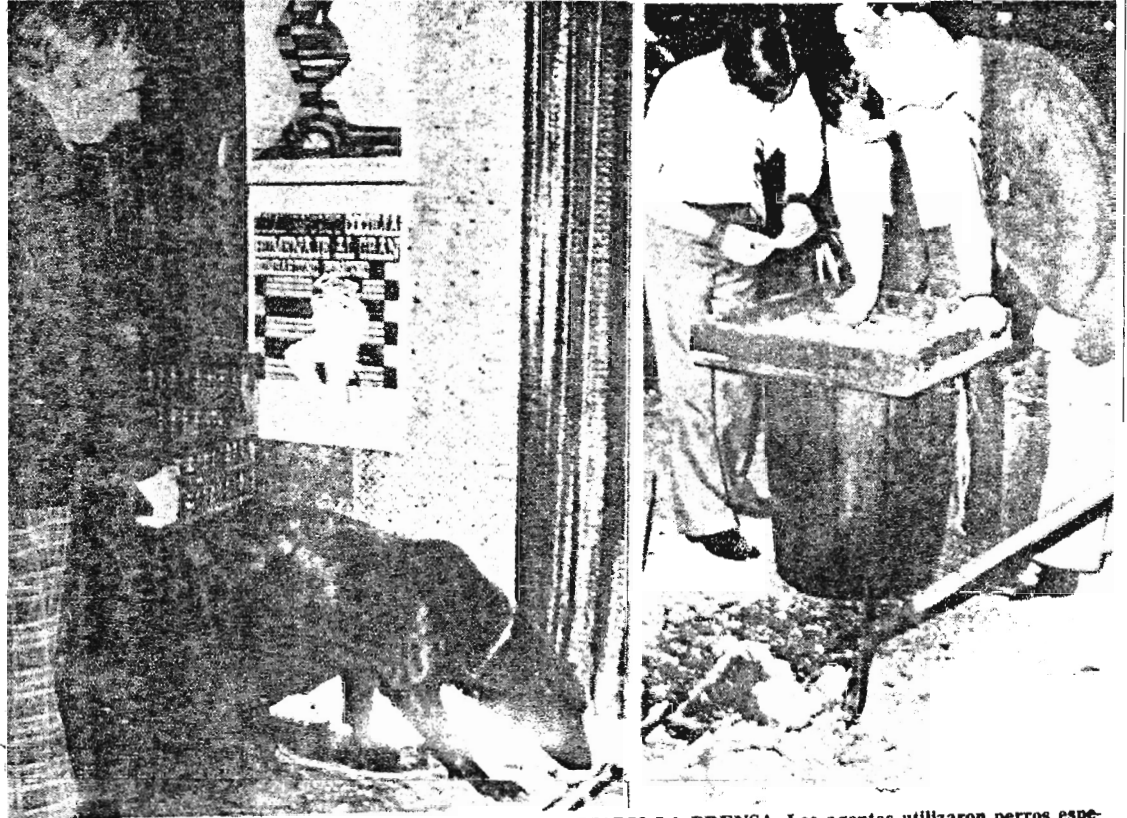
AGENTES DEL ESCUADRON DE EXPLOSIVOS del Departamento de Policía de Nueva York, realizan una minuciosa investigación entre los escombros producidos a raíz de la explosión de una bomba en las instalaciones de EL
