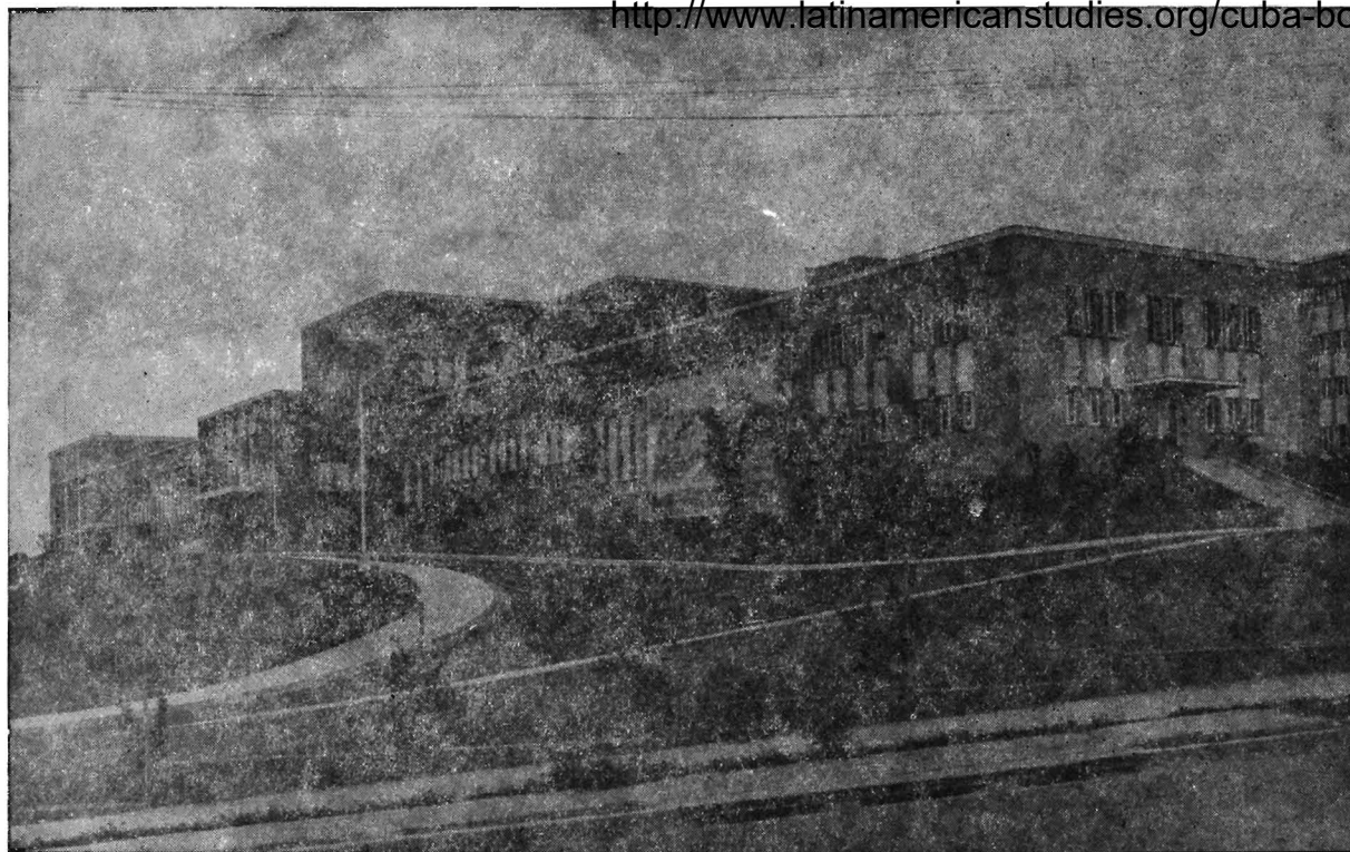
Dos de los diecisiete grandes hospitales nuevos que se construyeron a lo largo de Cuba, en su mayor parte erigidos en el interior de la República. Foto uno: Hospital Civil de la Provincia de Oriente, en Santiago de Cuba con 400 camas.
